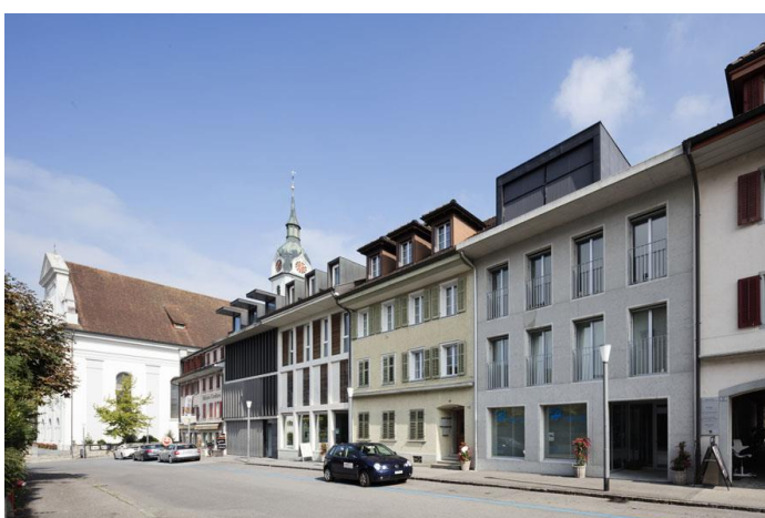
Bild 6: Drei Reihenhäuser, Oberstadtstrasse (© Gaetan Bally/Keystone)
