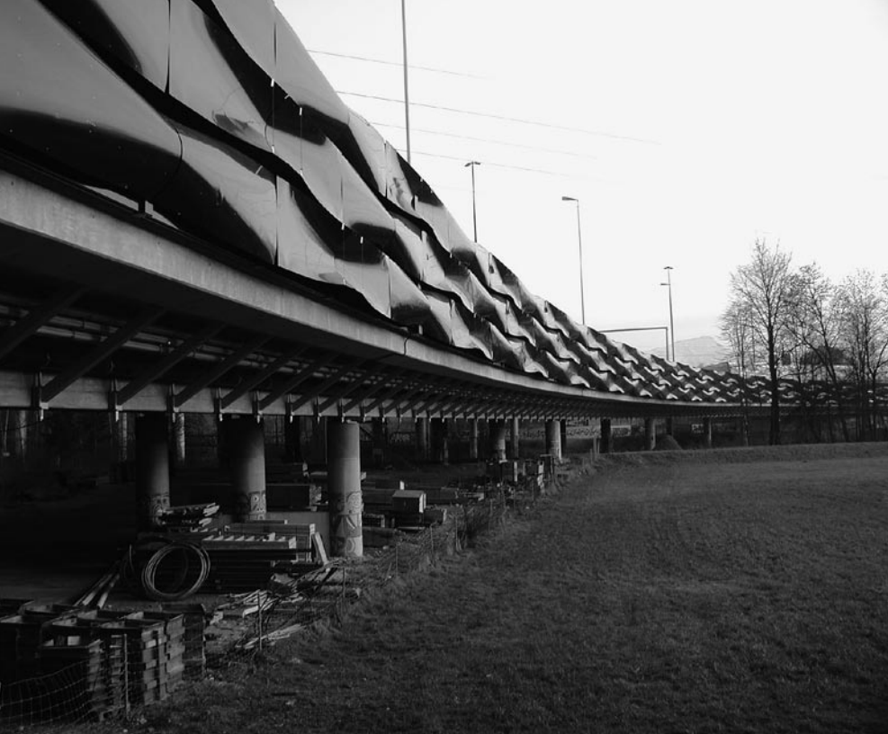
Die neuen Lärmschutzwände wurden auf der Aussenseite mit einer Metallstruktur veredelt.
