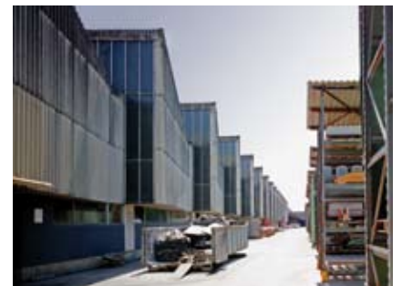
Tours de Carouge, Lucien Archinard, Edouard Barro, Georges Brera, Alfred Demay, Jean-Jacques Mégevand, René Schwertz und Paul Waltenspühl, 1958–69 (oben) Fabrikgebäude Eternit AG, Payerne, Paul Waltenspühl, 1956/57 Fotos: Dominique Marc Wehrli
