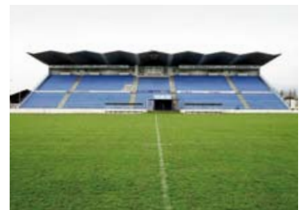
Parktheater Grenchen, Ernst Gisel, 1953–55 (oben) Tribüne FC Grenchen, C. Campoleoni und A. Christen, Ingenieure Stocker, Buser und Schneider, 1962 Fotos: Christoph Wider
