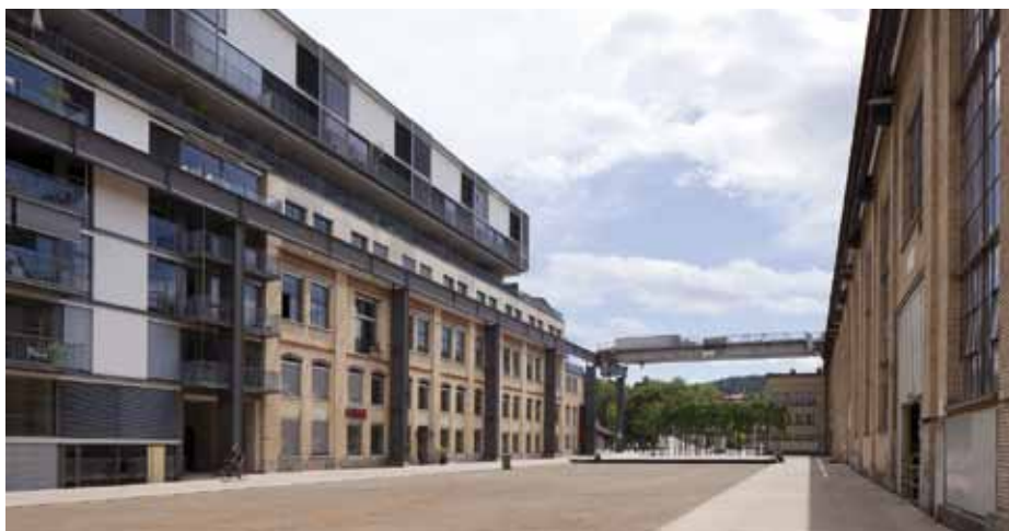
Auf einem ehemaligen Industrieareal führt ein dynamischer Transformationsprozess zu einem Mischgebiet mit Neubauten und modernen Nutzungen in bestehenden Gebäuden: Sulzer-Areal Winterthur, ab 1995, Sulzer Immobilien AG
