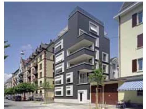
Eine der letzten Lücken im Quartier wird durch ein neues Stadthaus geschlossen, die Wohnungen erstrecken sich über Alt- und Neubau: Stadthaus Zurlindenstrasse, Zürich, 2004-2006, Huggenberger Fries Architekten
