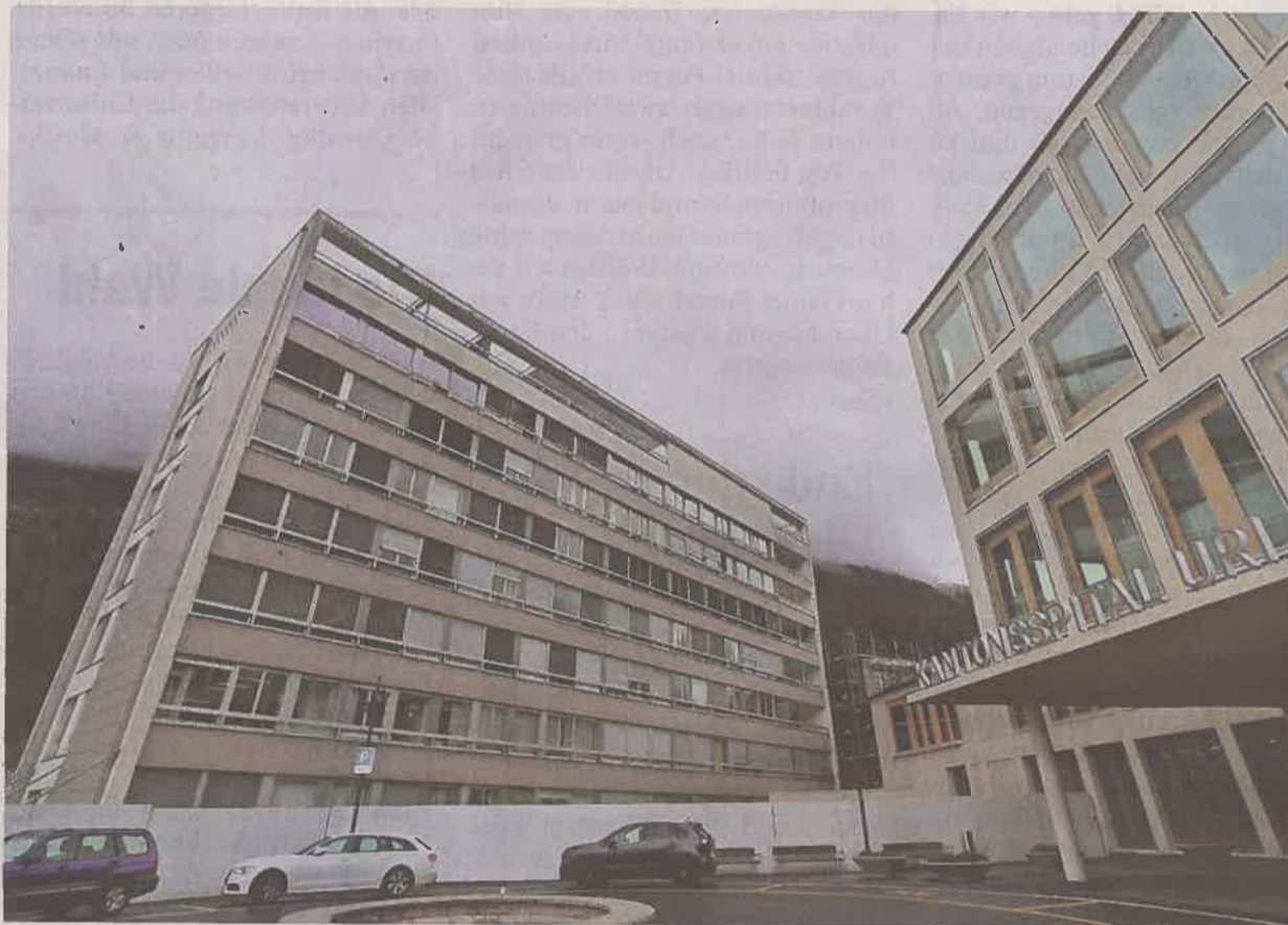
Rechts der Spitalneubau, links die Spitalbaute aus dem Jahr 1963. Könnten die beiden Gebäude nebeneinander stehen bleiben? Für den Spitaldirektor ist die Antwort klar: Nein. FOTO: DORIS M.
